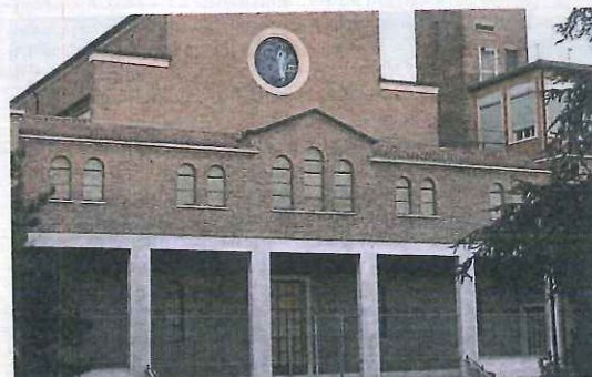
L'ingresso della chiesa dell'Opera di Santa Teresa
