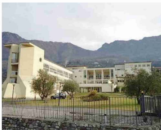
La struttura. Una veduta della Rsa Zirotti
