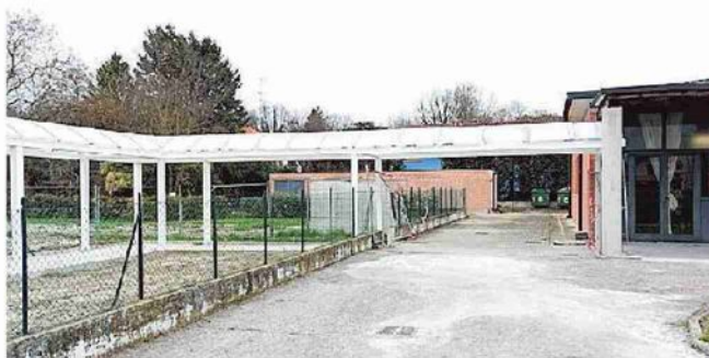
La pensilina in costruzione alla Rsa Bovi
